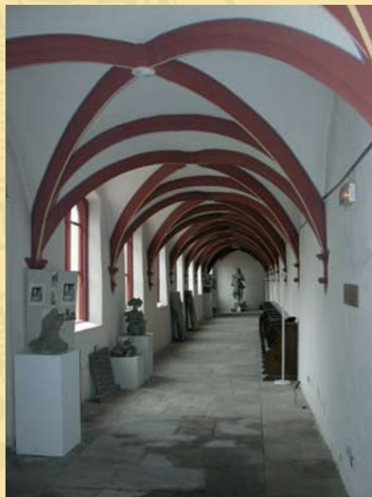
Partie transversale du cloître Kreuzgang Teil des Quergangs Transverse part of the cloister
